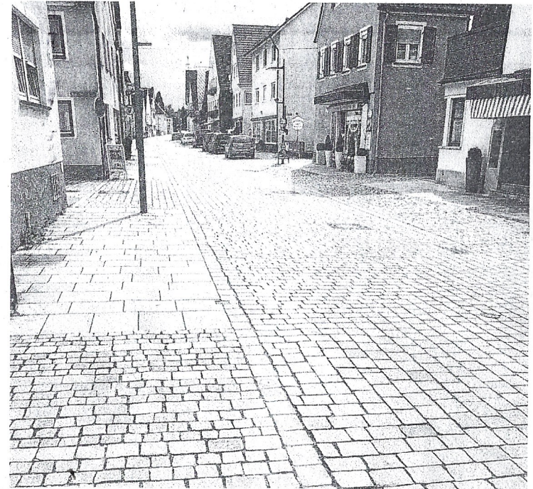
Mit einem Vergleich vor dem Landgericht ist der Prozess um den Pflasterbelag in der Memminger Straße zum Abschluss gekommen. Archivfoto: Andreas Brücken
