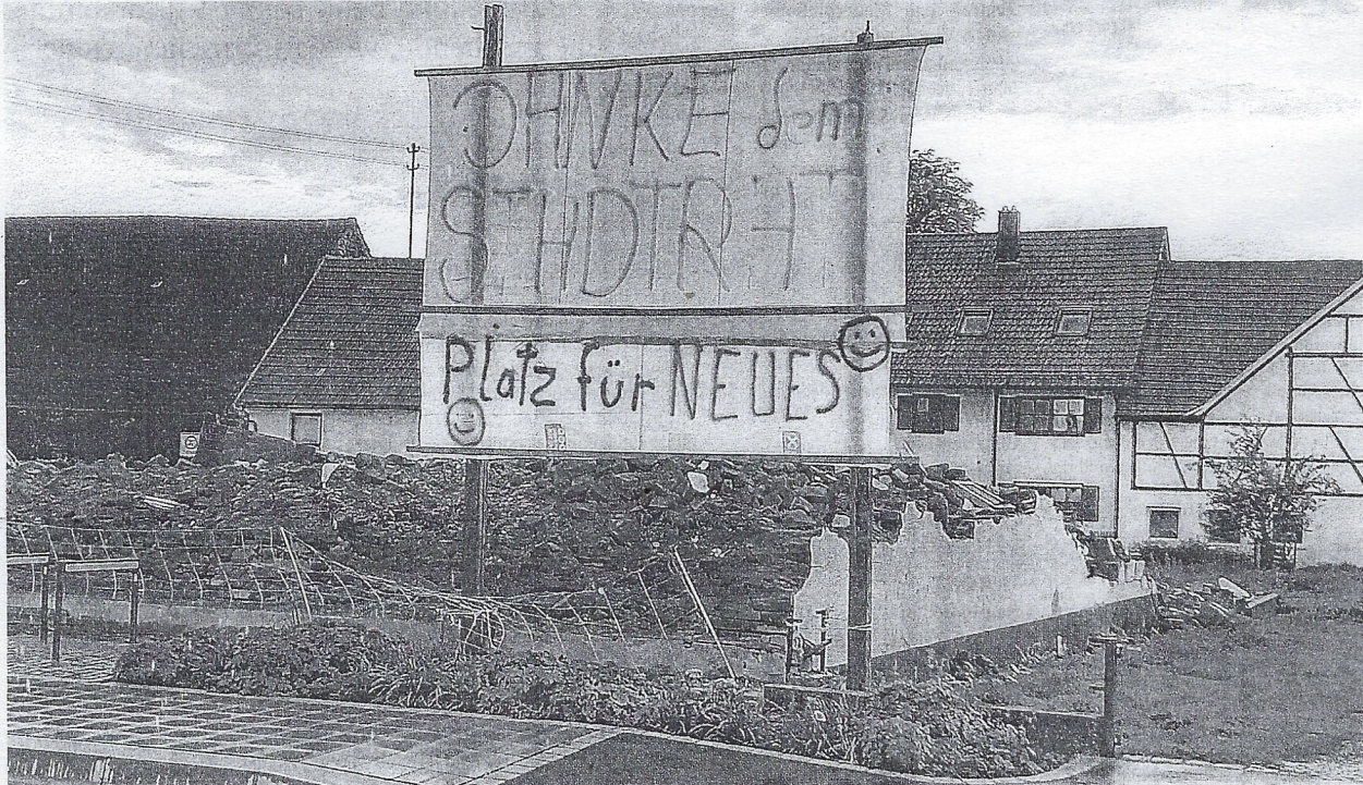
Auf eigene Faust und ohne Genehmigung haben die Eigentümer das alte Bauernhaus abgerissen, das auf Höhe der Haltestelle im Ortskern von Bubenhausen stand. Fotos: Noll
